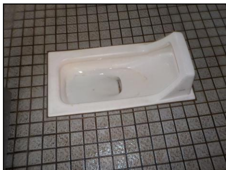
男子トイレ 大便器周辺床
