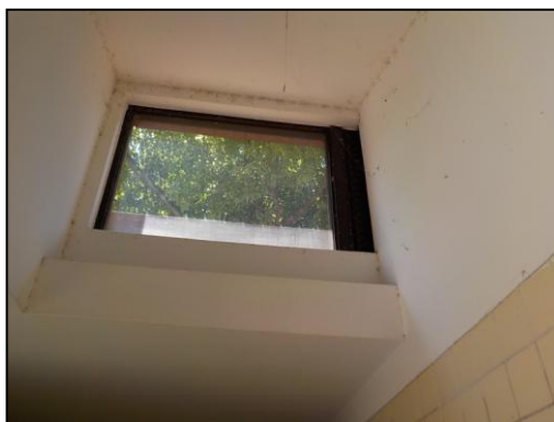
トイレ天井面・壁面
