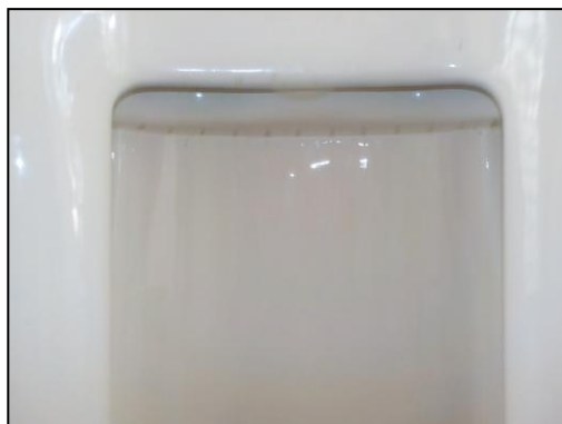
洗浄面 水垢汚れ
