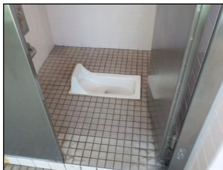
女子トイレ 大便器周辺床
