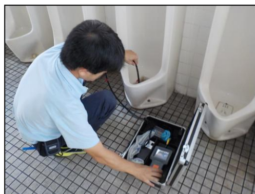
内視鏡による 小便器排水管内調査
