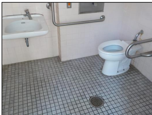
多目的トイレ床面
