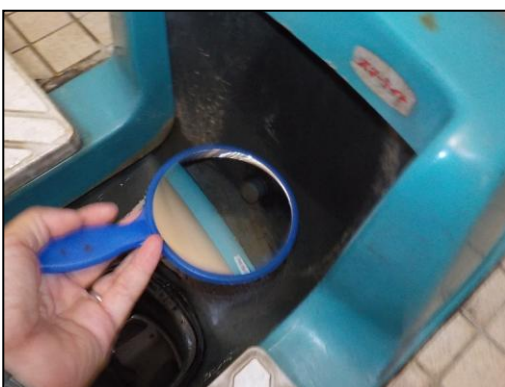
便器全体 水垢汚れ・傷
