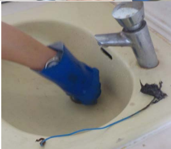
排水口から詰まりの原因を取り除く
