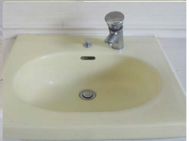
排水不良改善と清掃後の洗面台
